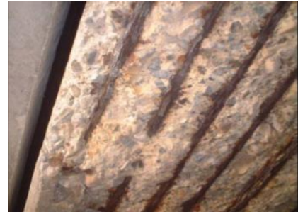
Hình-3 Hư hỏng bản mặt cầu bê tông xi măng
