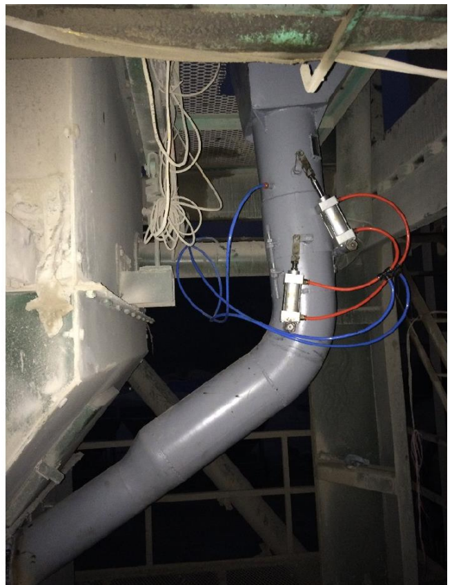
Hình 2: Ví dụ minh họa thiết bị cấp phụ gia TPP định lượng tự động kết nối trực tiếp với trạm trộn, hoạt động đồng bộ với trạm trộn về thời điểm cấp phụ gia, thời gian cấp.
