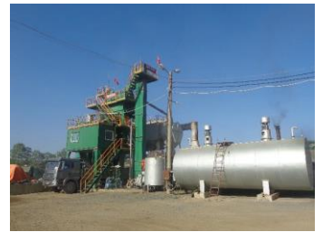
Trạm bê tông nhựa
