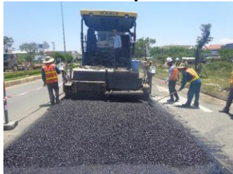
Rải hỗn hợp BTN
